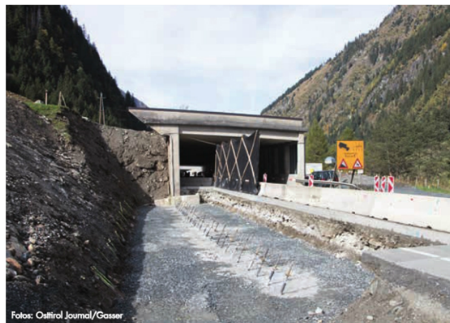
Aktuelle Arbeiten an der Voralp-Galerie auf der Nordseite
