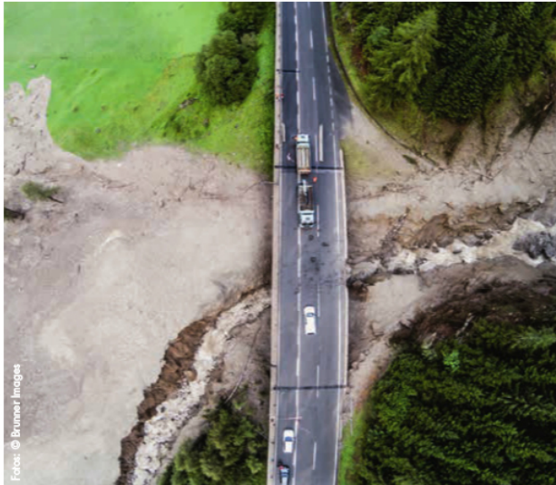
Bei der Petersbach-Brücke wurden nach einem Murenabgang im August dieses Jahres Sanierungsmaßnahmen notwendig.
