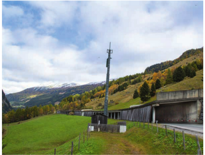
Die 50 Jahre alte Raneburg-Galerie wird in vier Etappen bis 2020 neu errichtet – ein Lawinenlenkdamm oberhalb der Galerie ist bereits fertiggestellt, an der Baustraße unterhalb der Galerie wird derzeit gearbeitet.
