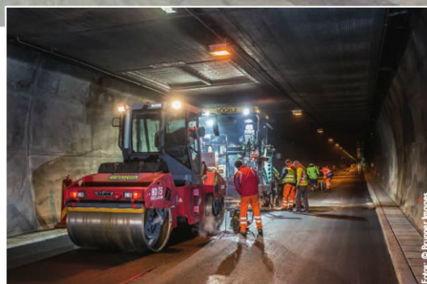
Die Belagssanierungsarbeiten im Tunnel und am Tunnelvorplatz erfolgten in den Nachtstunden vom 9. bis zum 20. Oktober 2017.
