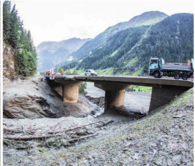
Bei der Petersbach-Brücke wurden nach einem Murenabgang im August dieses Jahres Sanierungsmaßnahmen notwendig.
